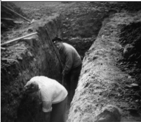
Ausschachten für den Keller
