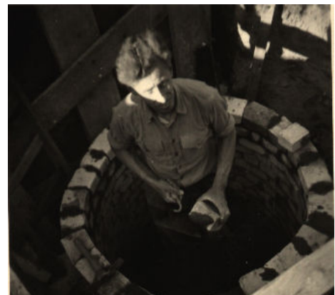
Mauern von Sickerschächten
